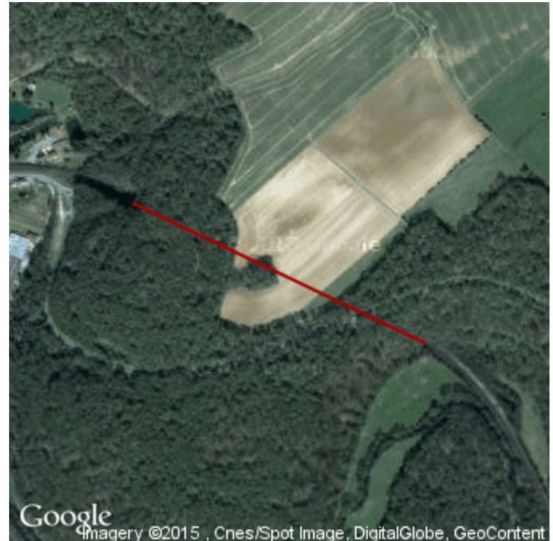
Photo : La Platinerie tunnel
