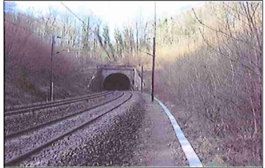
Photo : Martinsart tunnel
